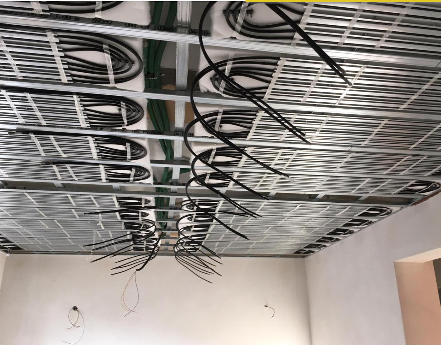
In alto, impianto radiante a soffitto efficace sia per il riscaldamento invernale che per il raffrescamento estivo (in abbinamento ad un deumidificatore);
