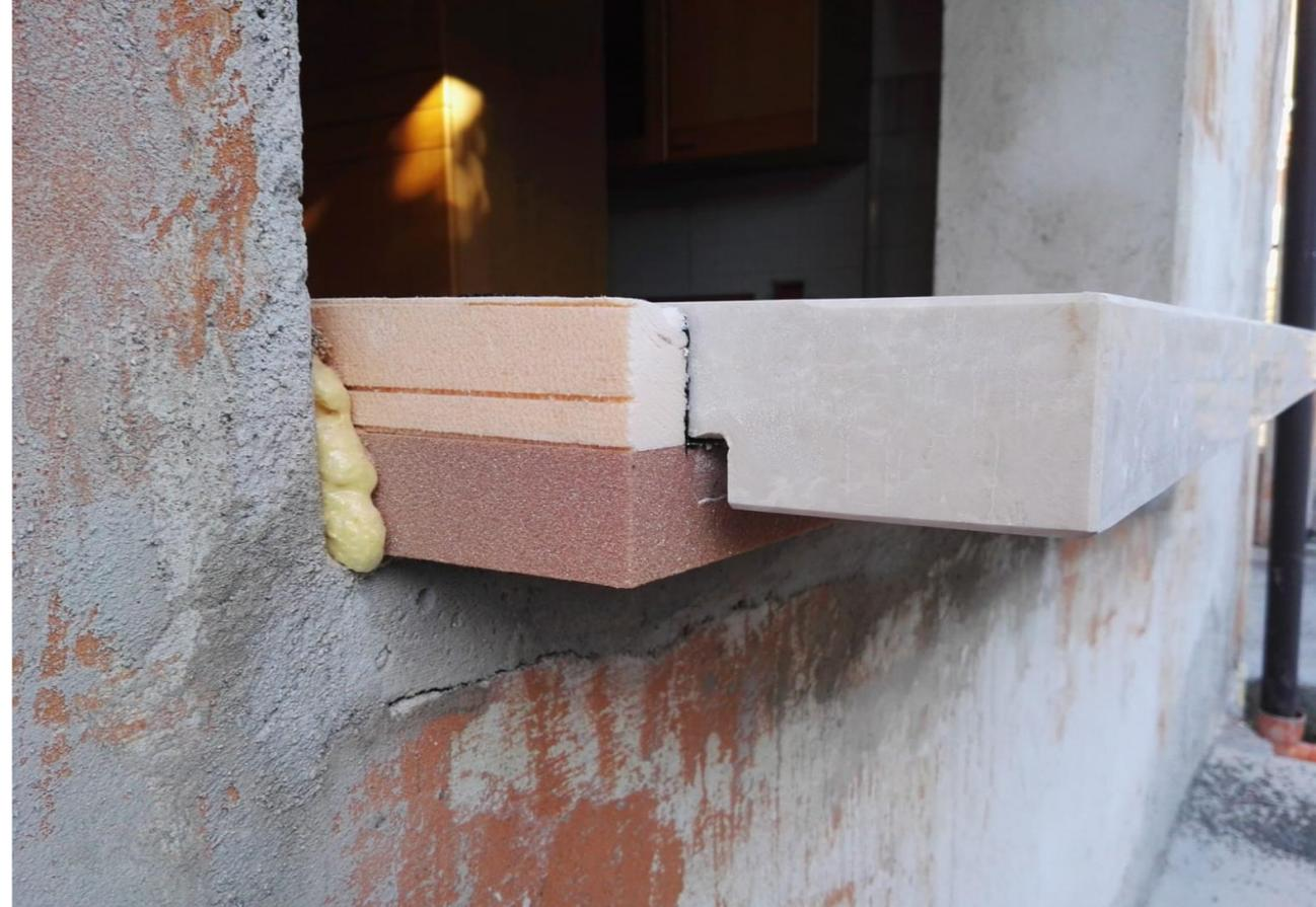
In alto sottobancale isolante; di fianco ed in basso, monoblocco termico e schiuma poliuretanic di tipo "viscoelastica", che ha funzione di coibentazione termica ma anche di isolamento acustico.
