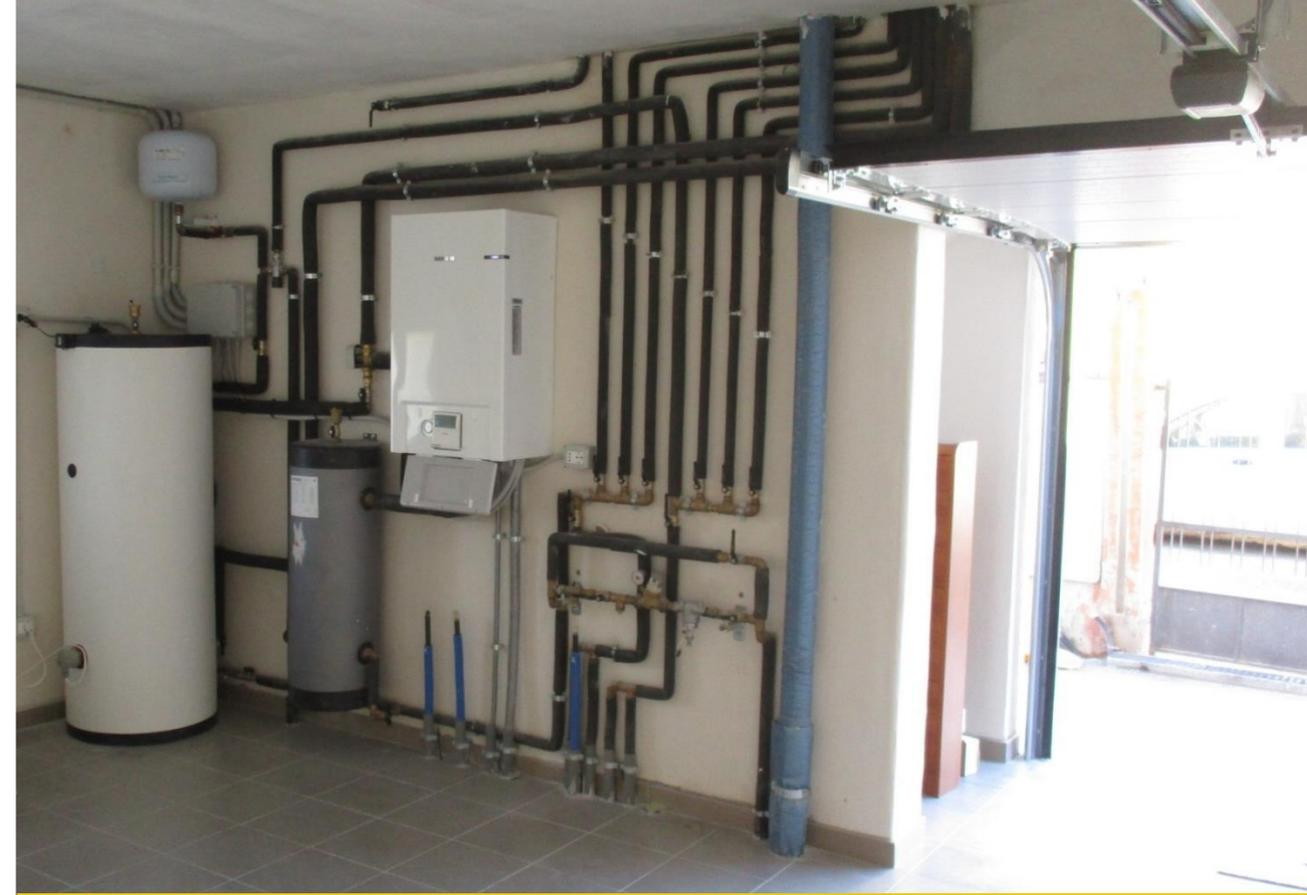
...Quindi impiegando una pompa di calore per l'alimentazione del sistema radiante a soffitto.
