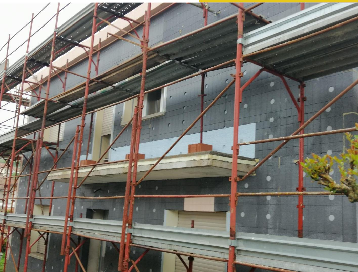
L'edificio è stato interamente coibentato con un cappotto esterno in EPS (polistirene espanso) grigio caricato a grafite. Questo materiale è in grado di "riflettere" il calore e di mantenerlo all'interno dell'involucro termico riscaldato.
