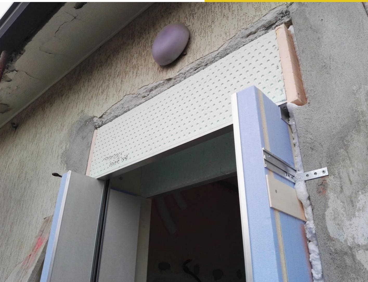
I monoblocchi di porte e finestre sono stati progettati e posati in modo da garantire un perfetto isolamento termico ed acustico di tutti i fori perimetrali, attraverso le nastrature sia interne che esterne (che garantiscono la tenuta all'aria e al vento) e soprattutto con la posa della schiuma poliuretanic.
