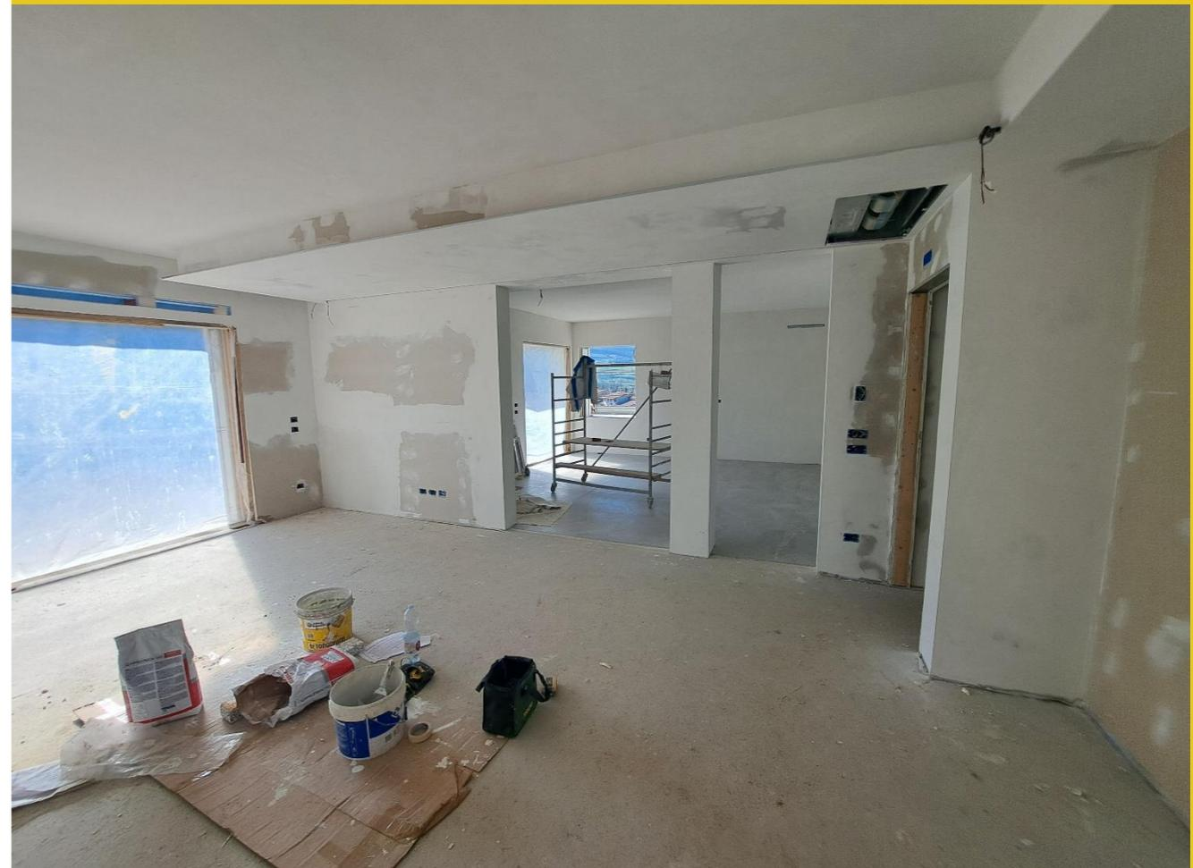
Le soluzioni impiantistiche sono state perfettamente integrate negli ambienti, grazie alla realizzazione di controsoffittature studiate ad hoc, che non solo "nascondono" le componenti impiantistiche, ma ospitano, dove previsto, il nuovo sistema di illuminazione led.
